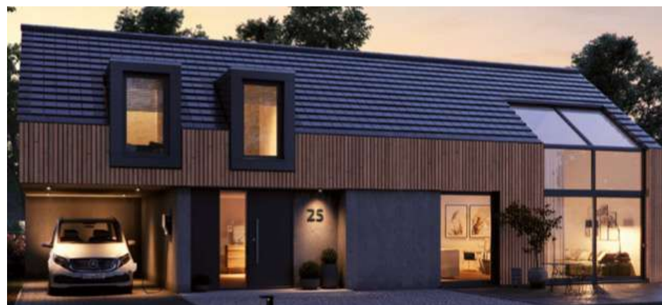
Impianto FV integrato
