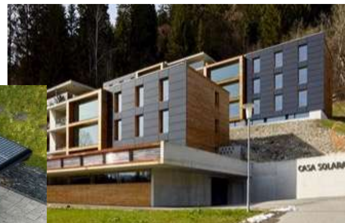
Impianto FV su facciata
